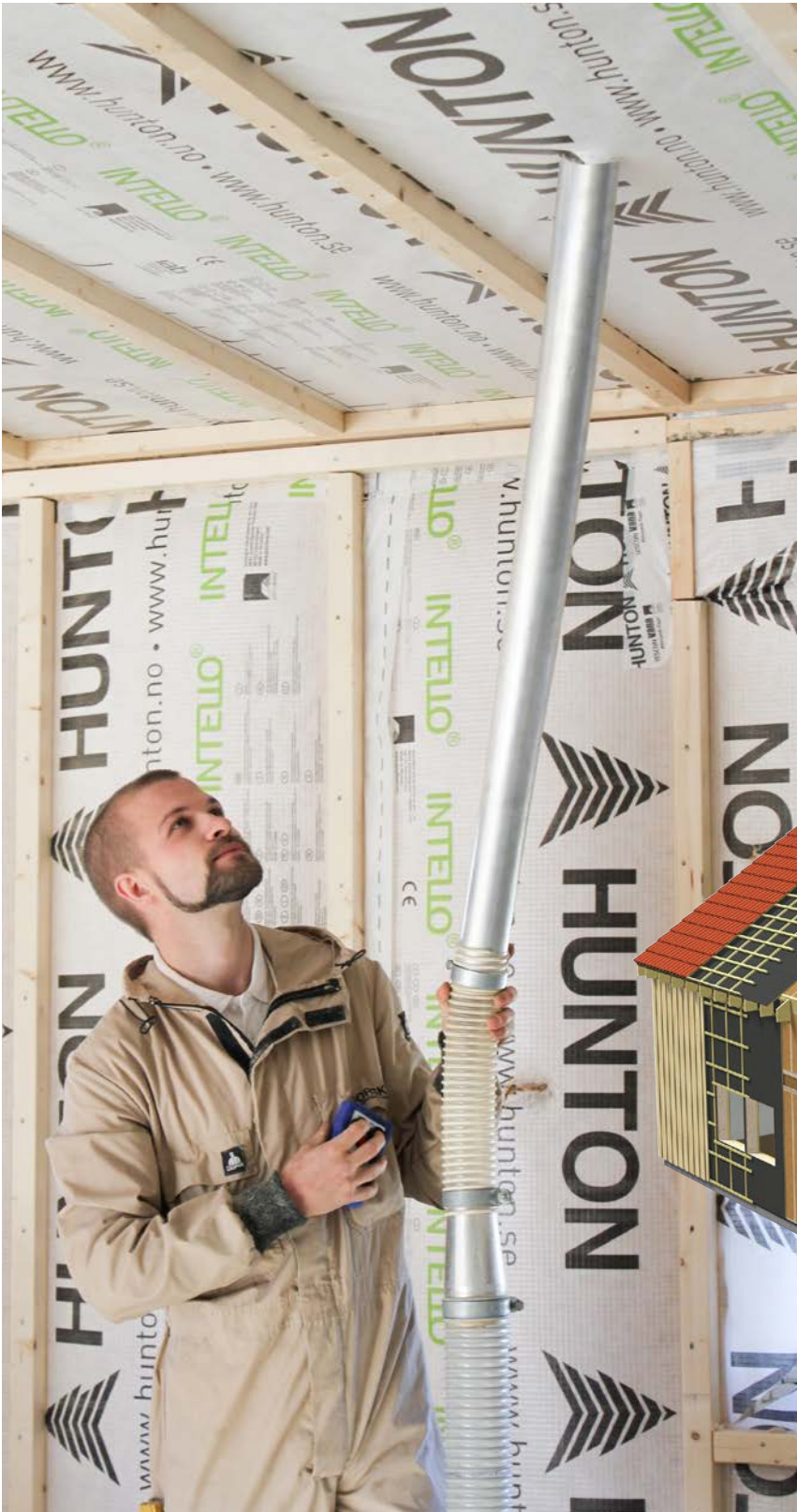
Illustrationen visar vägg blåsisolerad med Nativo Träfiberisolering.
